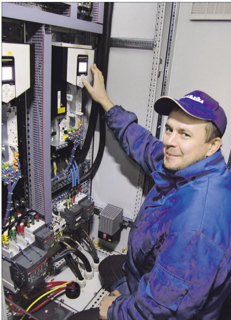
Инженер Александр Белик ведёт наладку привода бурового шарошечного станка СБШ 1570 по техническому заданию ОАО «Карельский окатыш»
