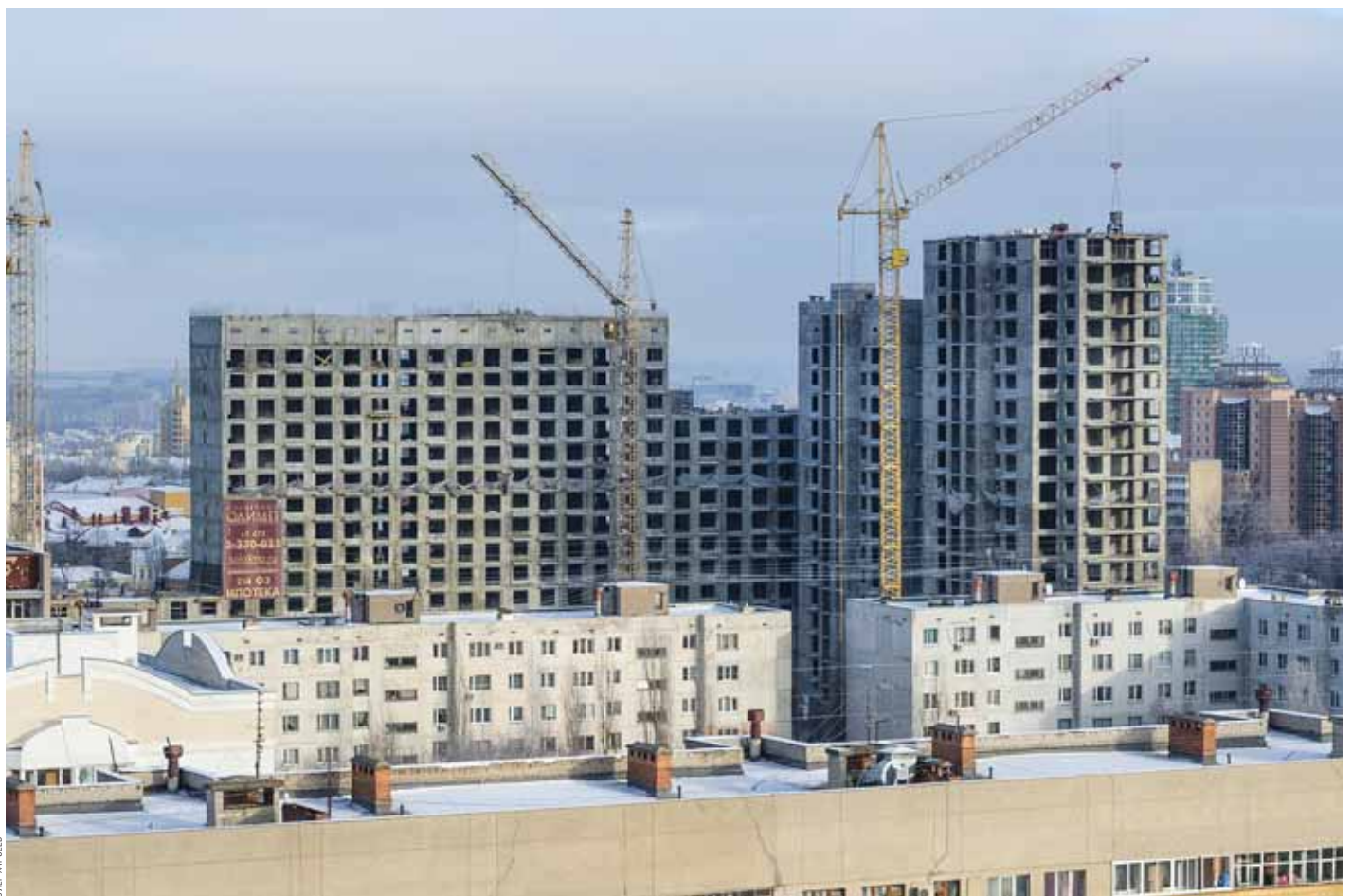
ВОЗВЕДЕНИЕ ЖИЛЬЯ БИЗНЕС-КЛАССА ВНОВЬ ВХОДИТ В ТРЕНД
