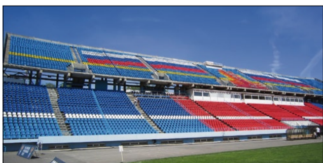
Стадион «Труд» — одна из главных визитных карточек Воронежа. Он выглядит очень нарядно благодаря ярким креслам, которые сделал «Рудгормаш». Кстати, наших кресел, а значит, и мест для зрителей на этой арене — 32 750
