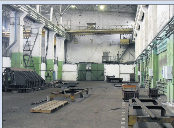
В минувшем месяце началась реконструкция и в 3-м цехе. Три пролёта перестраиваются, демонтировано старое оборудование, идет ремонт станков, которые будут установлены в обновлённом цехе, докупаются новые машины (например, уже приобретено 4 украинских сварочных выпрямителя, ручные газорезательная и кромкострогательная машины). Цех будет специализироваться на выпуске вакуумных фильтров, на которые сегодня на рынке большой спрос.
